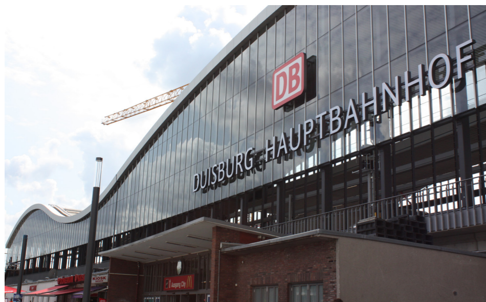
Am Osteingang des Duisburger Hauptbahnhofs ist das wellenförmige Erscheinungsbild der neuen Gleishalle bereits zu bewundern.
